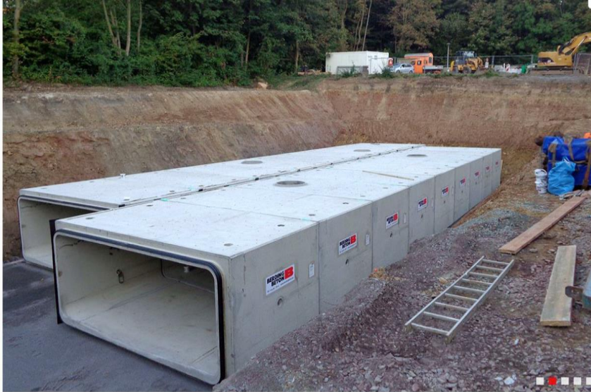
Beispielbild: Regenrückhaltung über Staukanal
