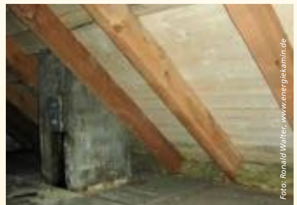
Hier fehlt die Dämmung der obersten Geschossdecke. Dadurch gibt es große Wärmeverluste. Eine Dämmung ist hier unbedingt erforderlich.
