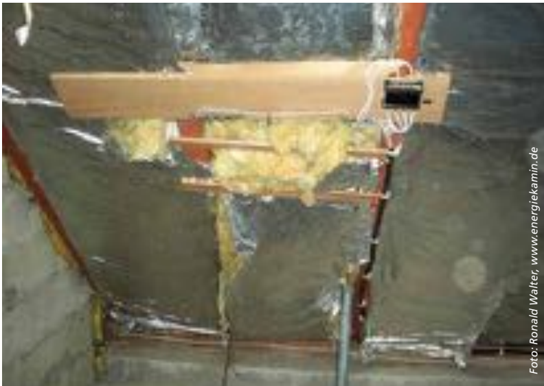
Schadhafte Zwischensparrendämmung. Hier hat die Dämmung keine Wirkung mehr.
